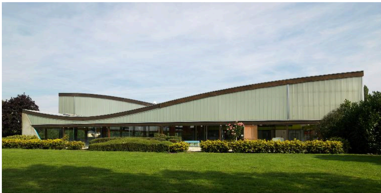
Façade sud (donnant sur la pataugeoire et le petit bassin).
