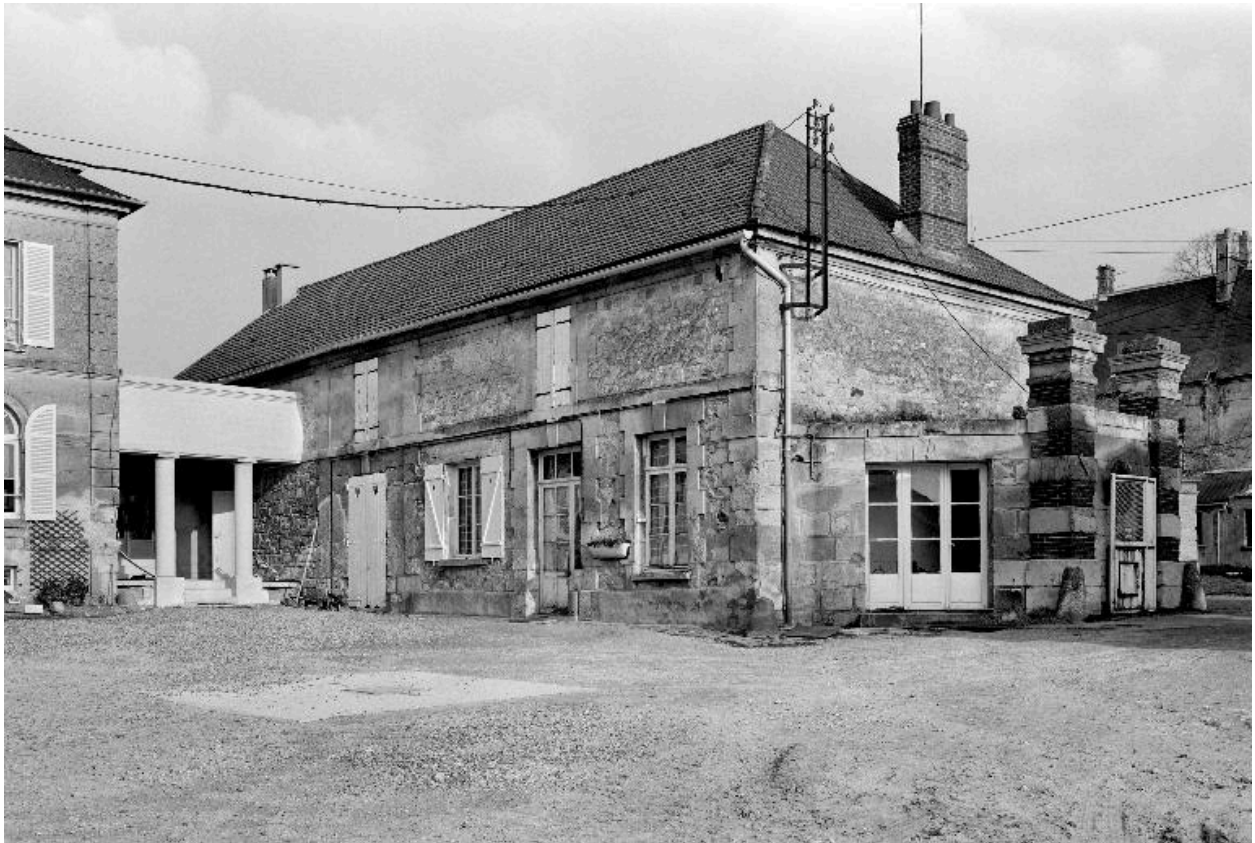
Élévation sur cour des bâtiments sud-est.
