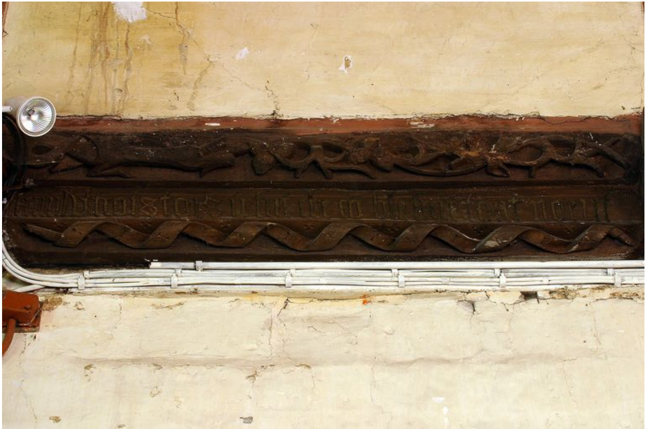
Vue détaillée de l'inscription présente sur la sablière haute du choeur.
