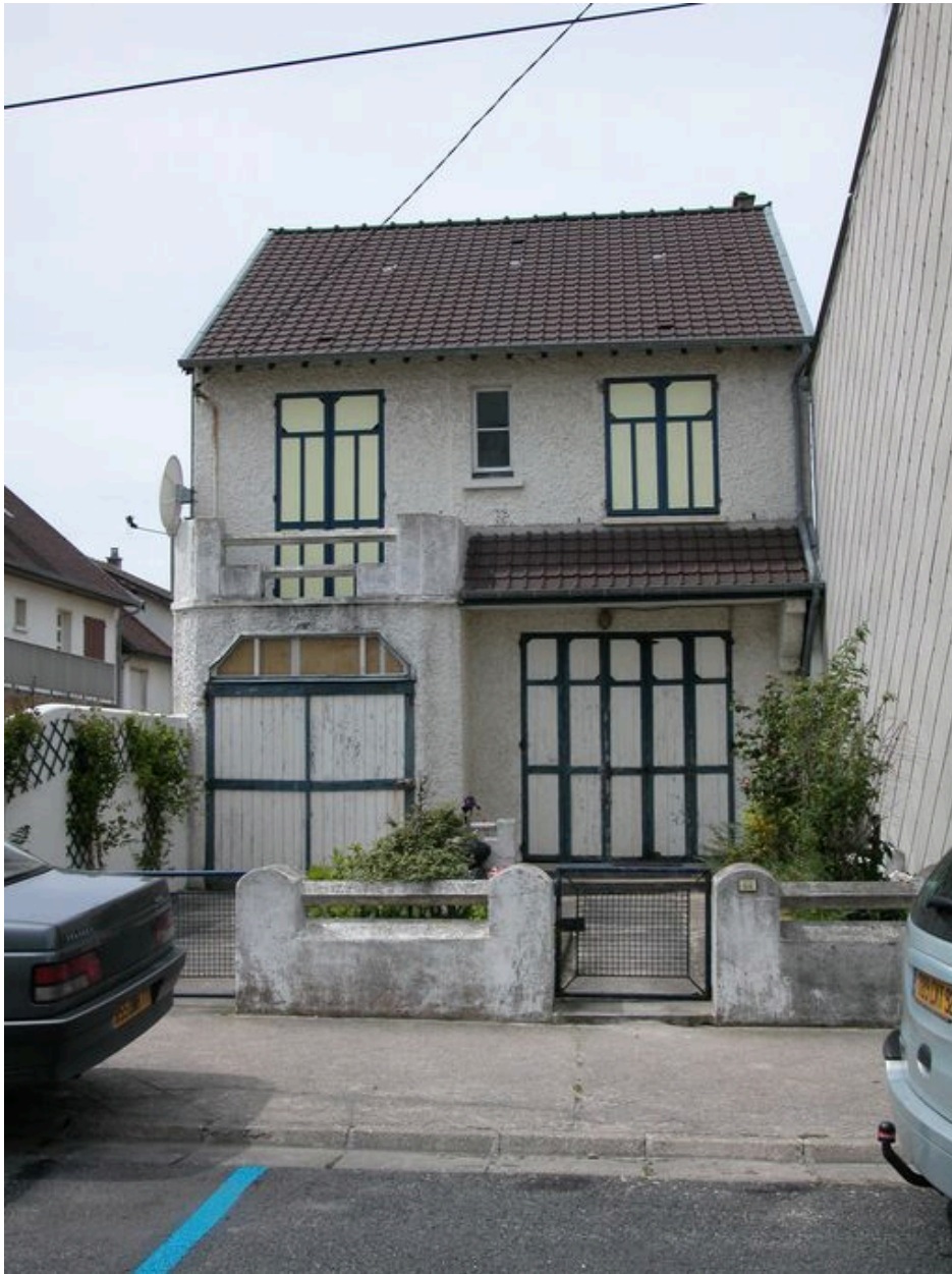
Clôture avec garde-corps carrés (44 rue des Dunes).
