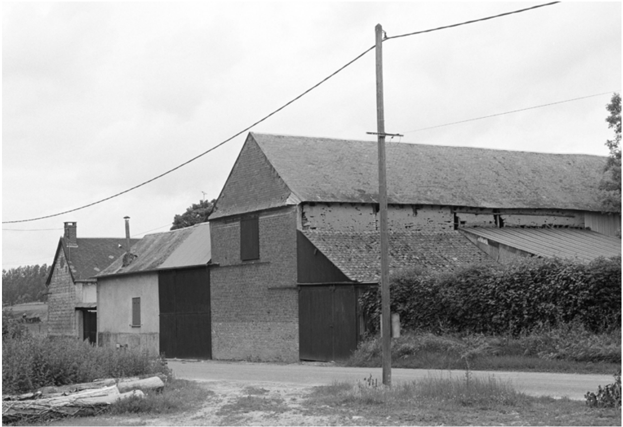
Vue d'ensemble des bâtiments sur rue, depuis le sud-ouest.
