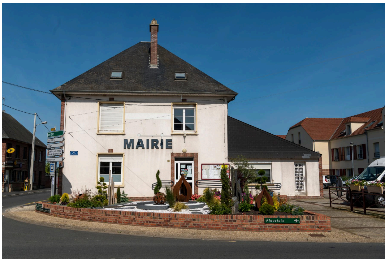
Mairie, n°1 rue de Provinlieu, vue depuis l'est.
