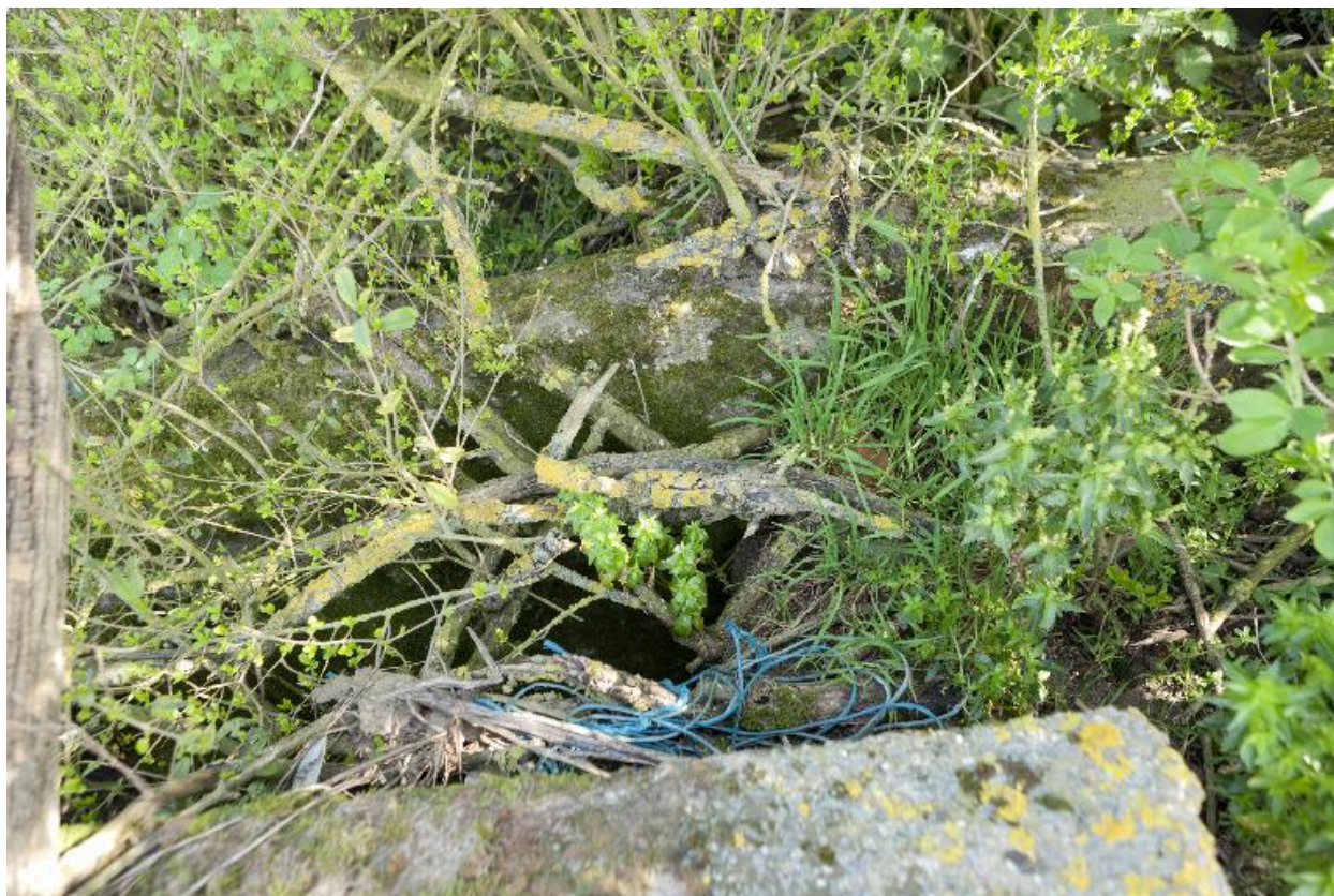
Rigole menant au bâtiment 1, partiellement découverte
