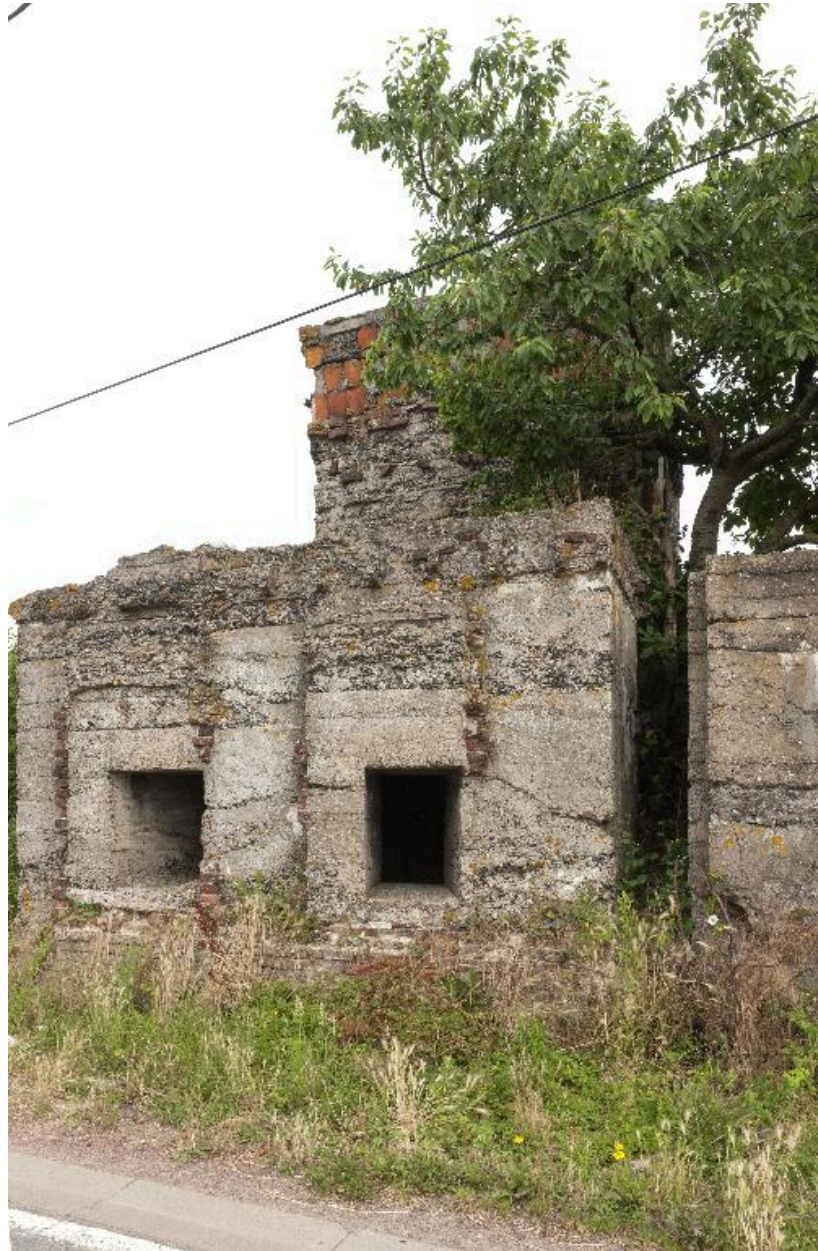
Casemate a, élévation antérieure. Une des ouvertures est biaise.
