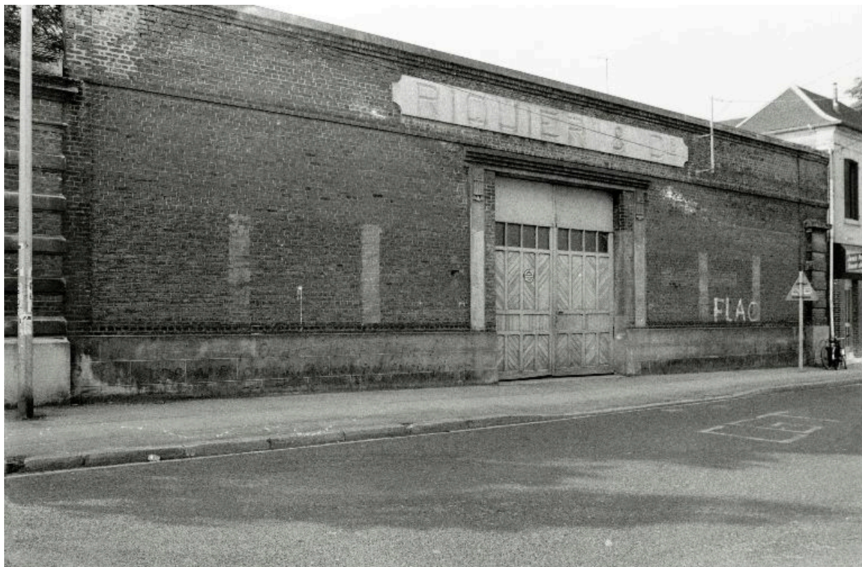
L'entrepôt, rue Roger-Salengro, en 1988.
