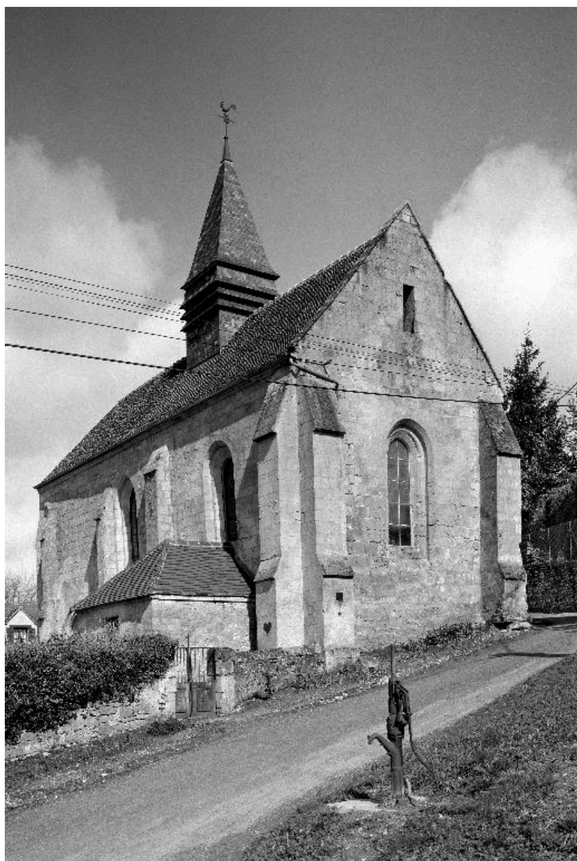
Vue générale de l'église, depuis le sud-est.
