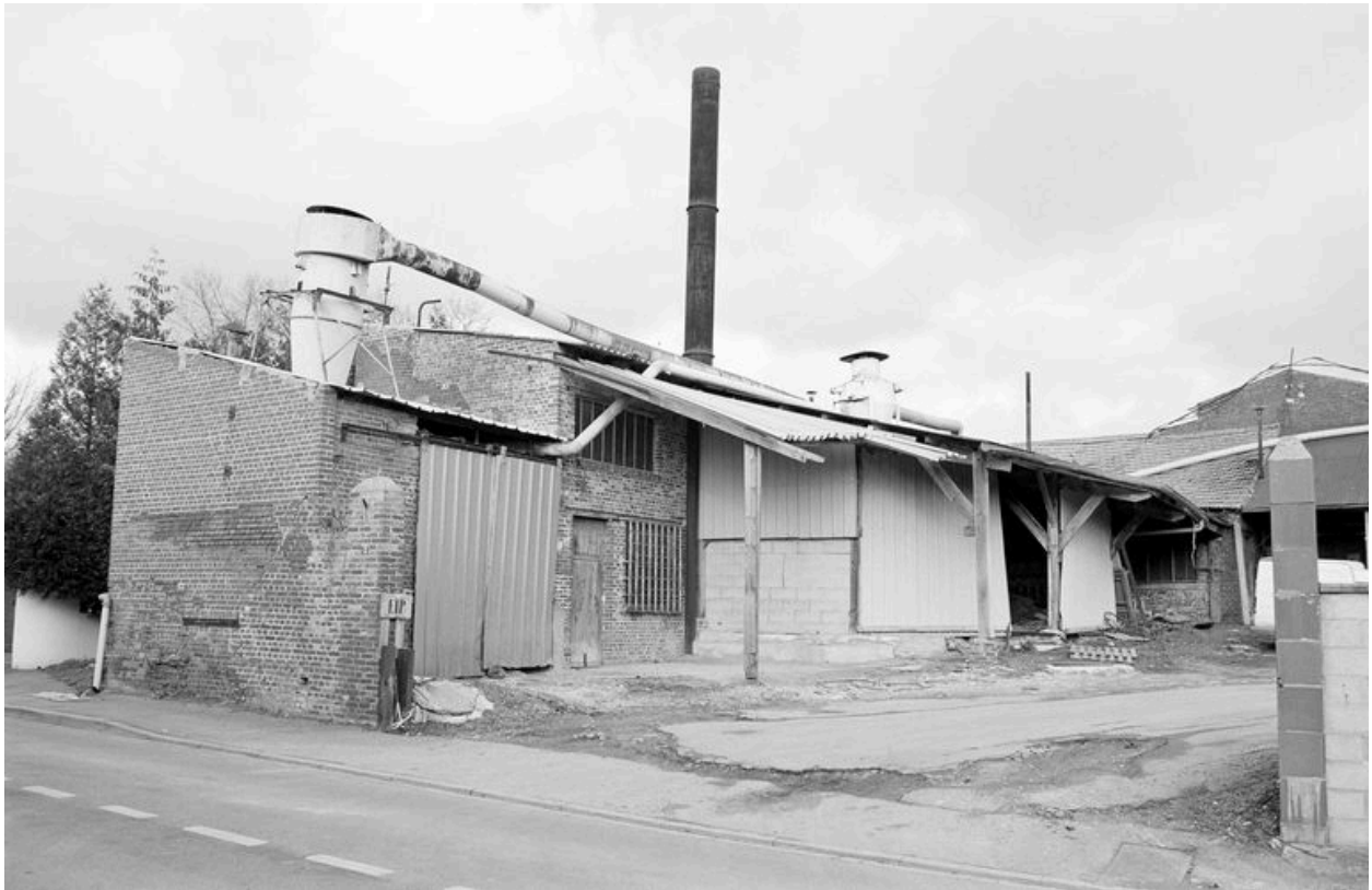
Chaufferie avec sa cheminée métallique.
