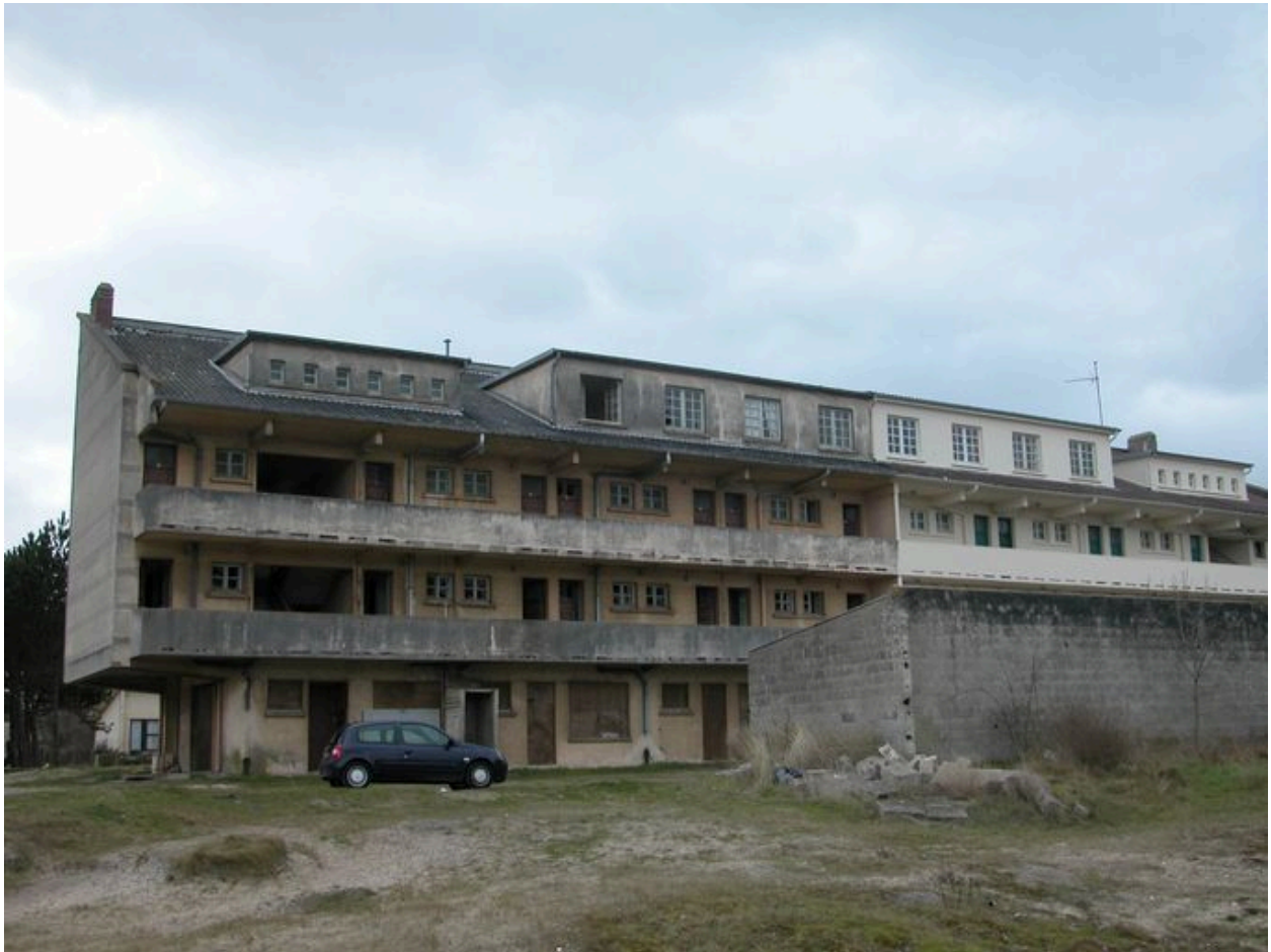
Façade postérieure avec coursières d'accès aux logements (La Renaissance, avenue Vasseur).
