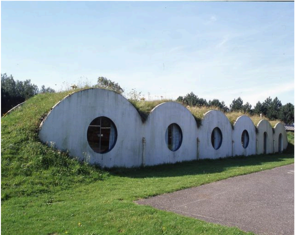
Élévation postérieure des bungalows.
