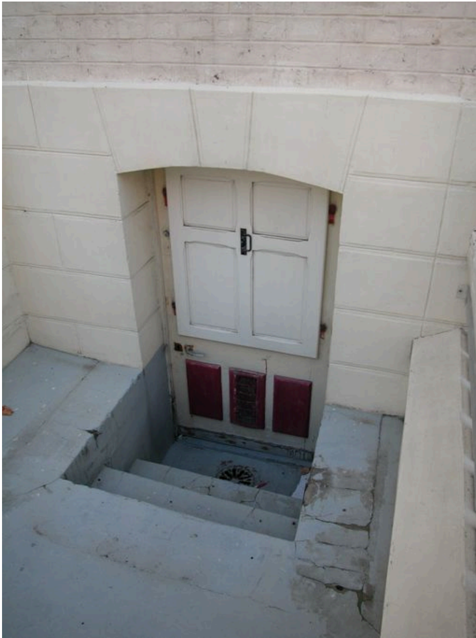
La porte d'accès au sous-sol.
