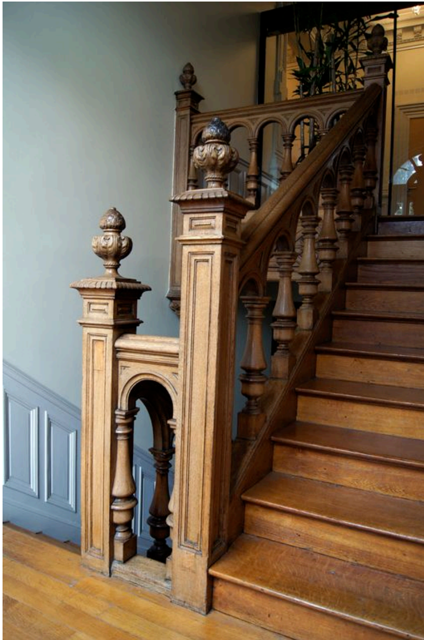
Vue de la rampe d'escalier.
