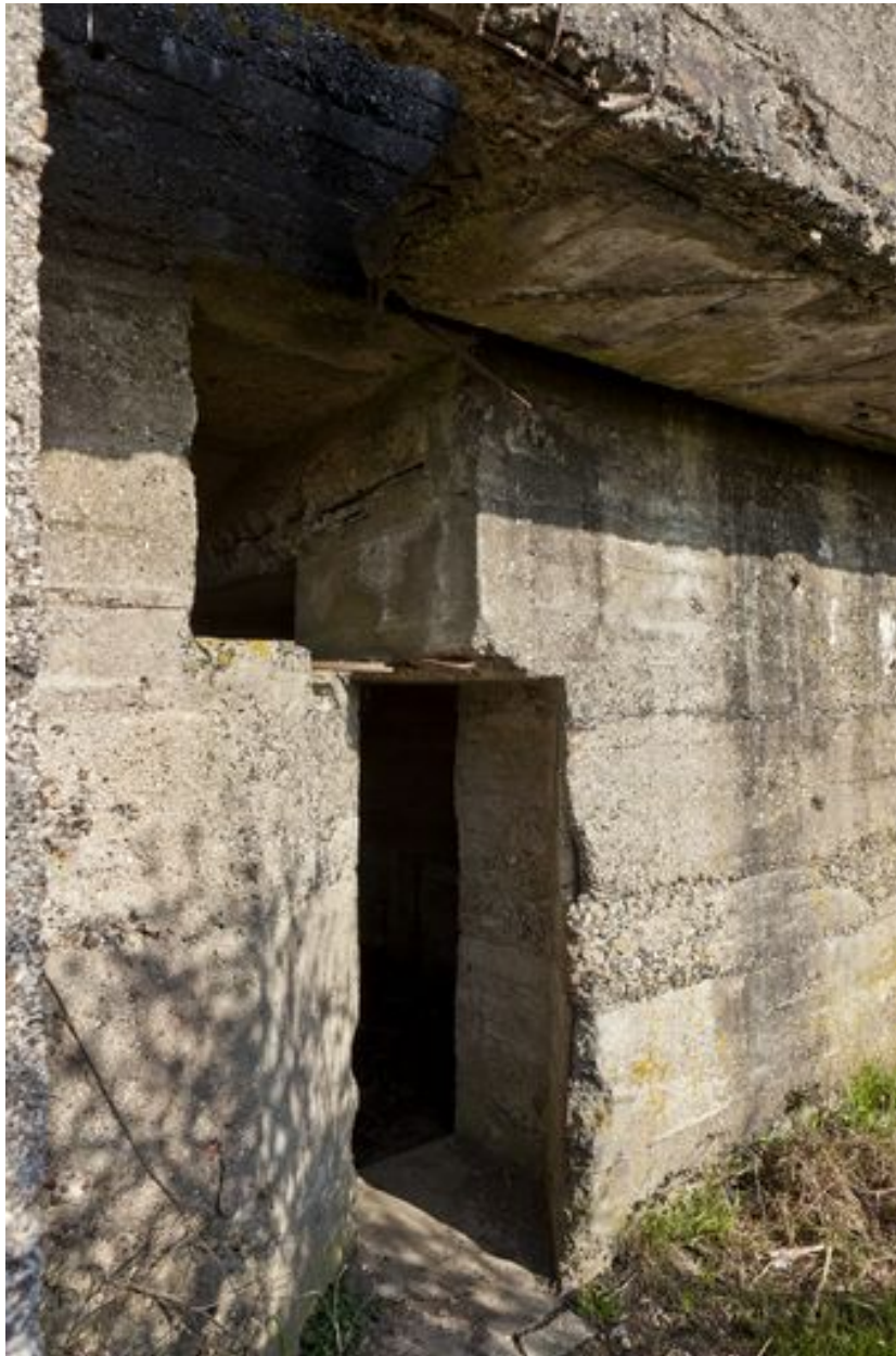
Elévation sud. Entrée secondaire et passage des canalisations d'eau, vers le nord-est.
