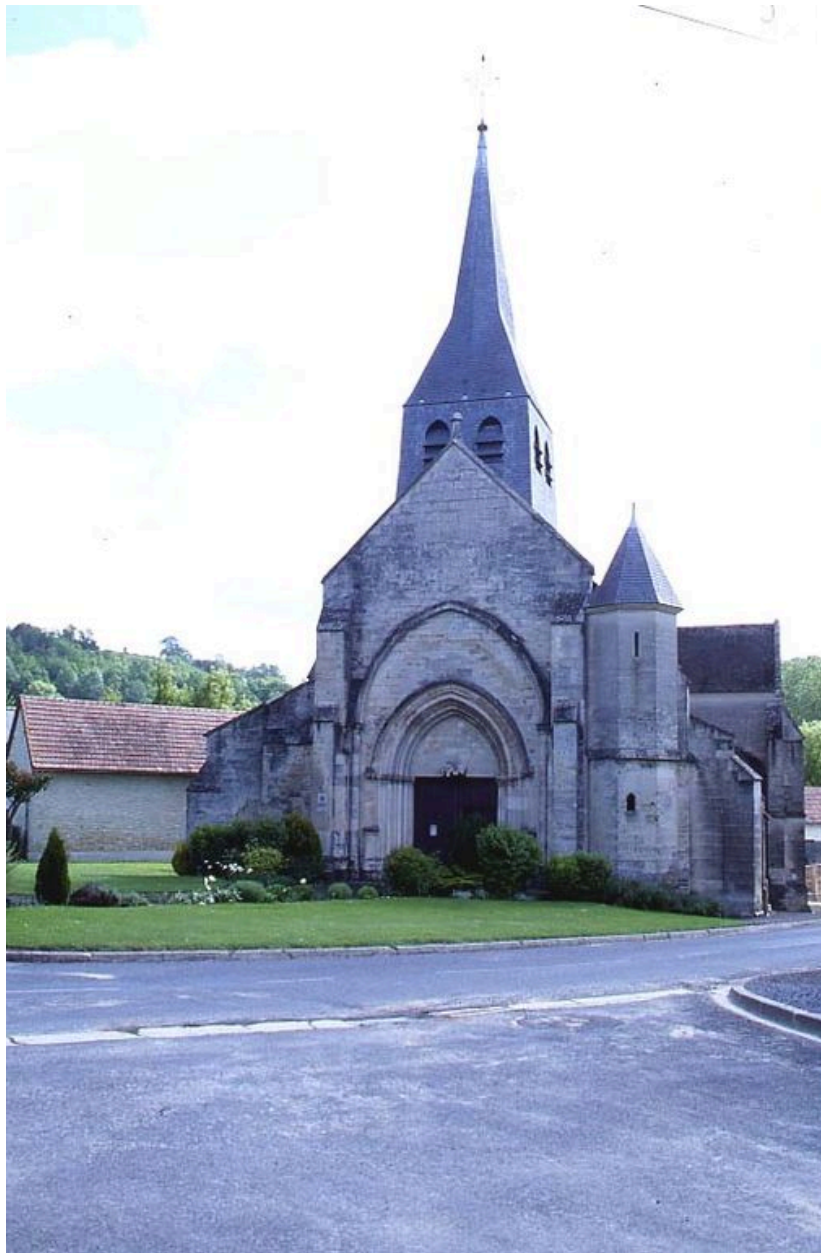
Vue de la façade ouest.
