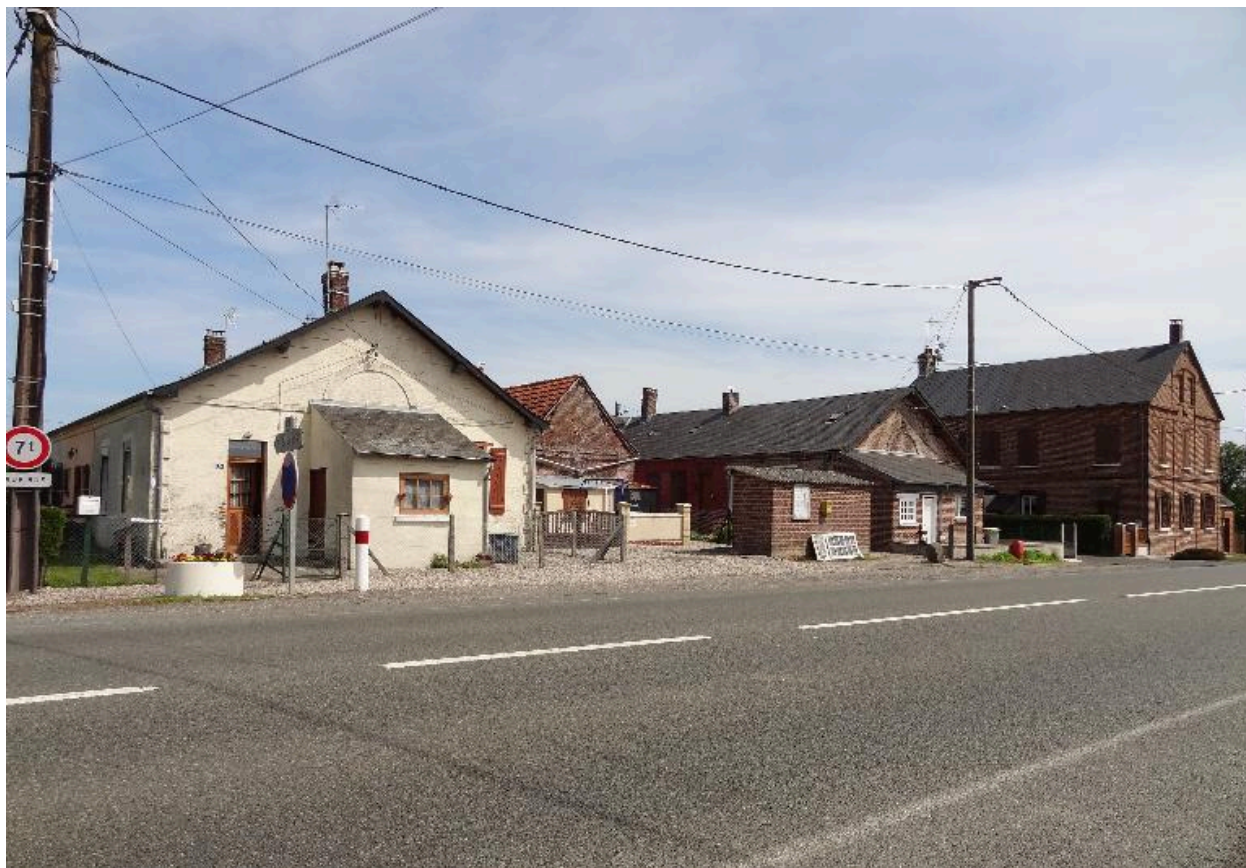
Ancienne usine et cité ouvrière Lainé.
