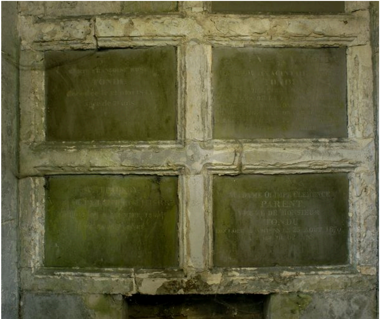
Vue des tables en marbre, à l'intérieur du tombeau.
