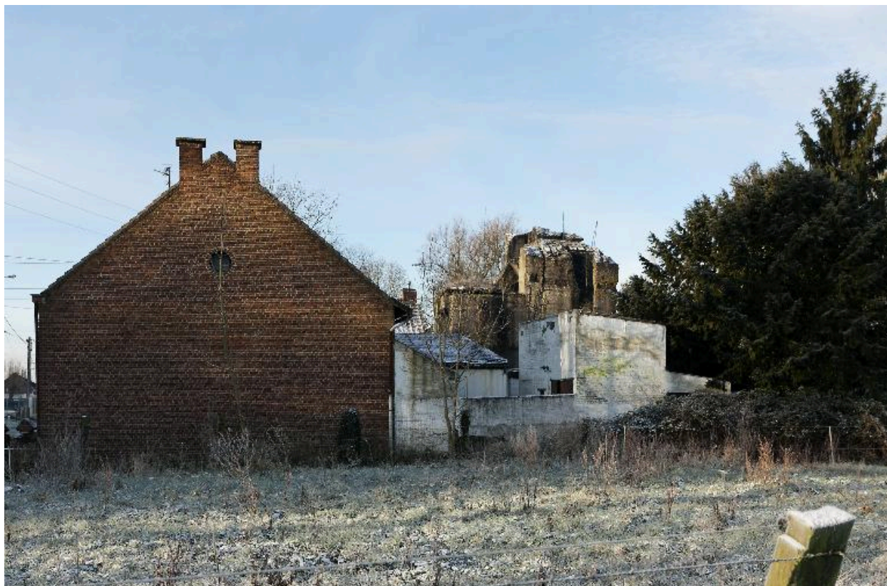
vue générale vers vers le sud
