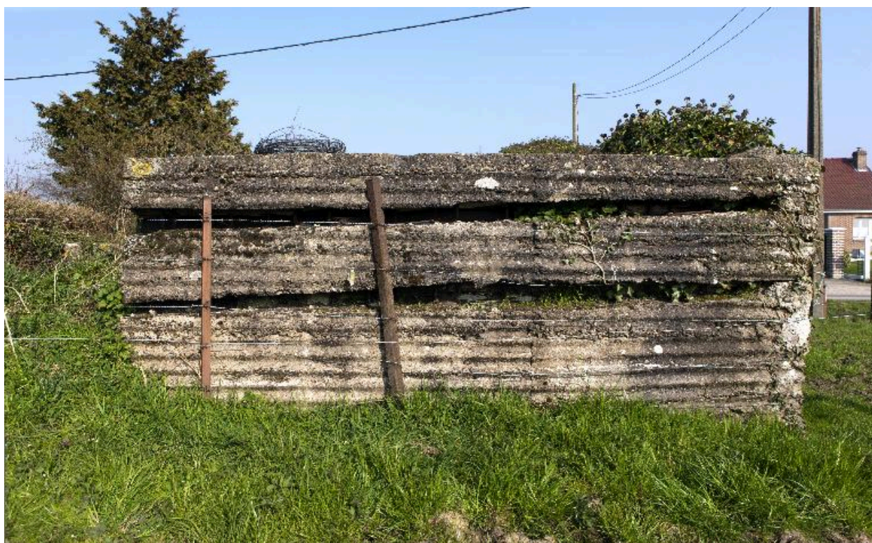
Elévation ouest, cellules d'éclatement (?)
