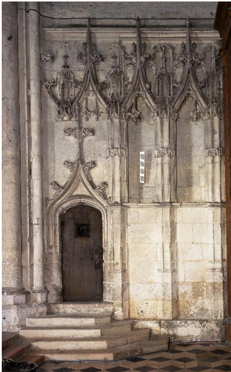
Vue des niches sculptées au revers de la façade sud du transept.
