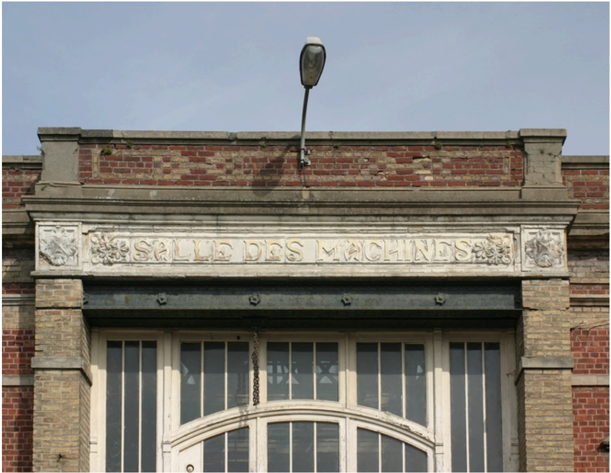
Salle de machines de 1913, détail.
