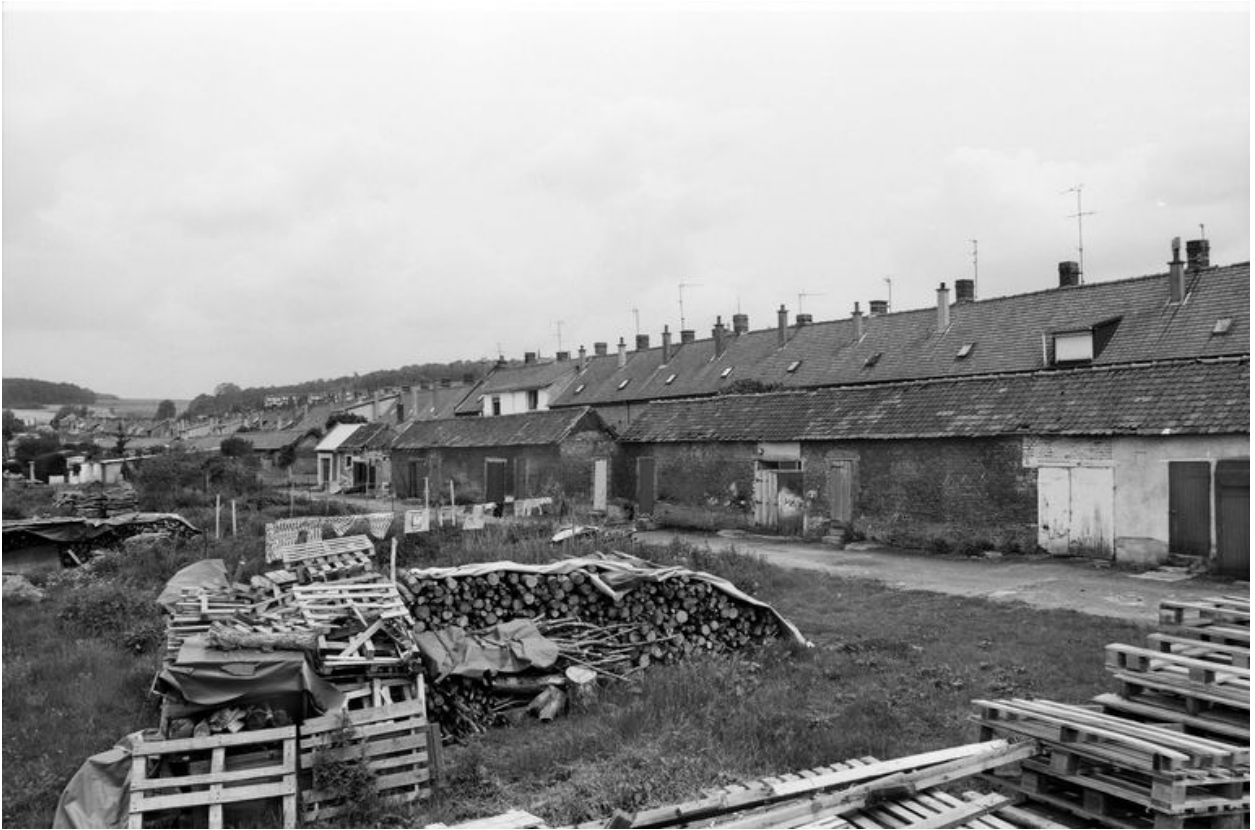
Logements d'ouvriers (rue des Moulins-Bleus, AM 120 à 159) , en 1991 : élévation antérieure.
