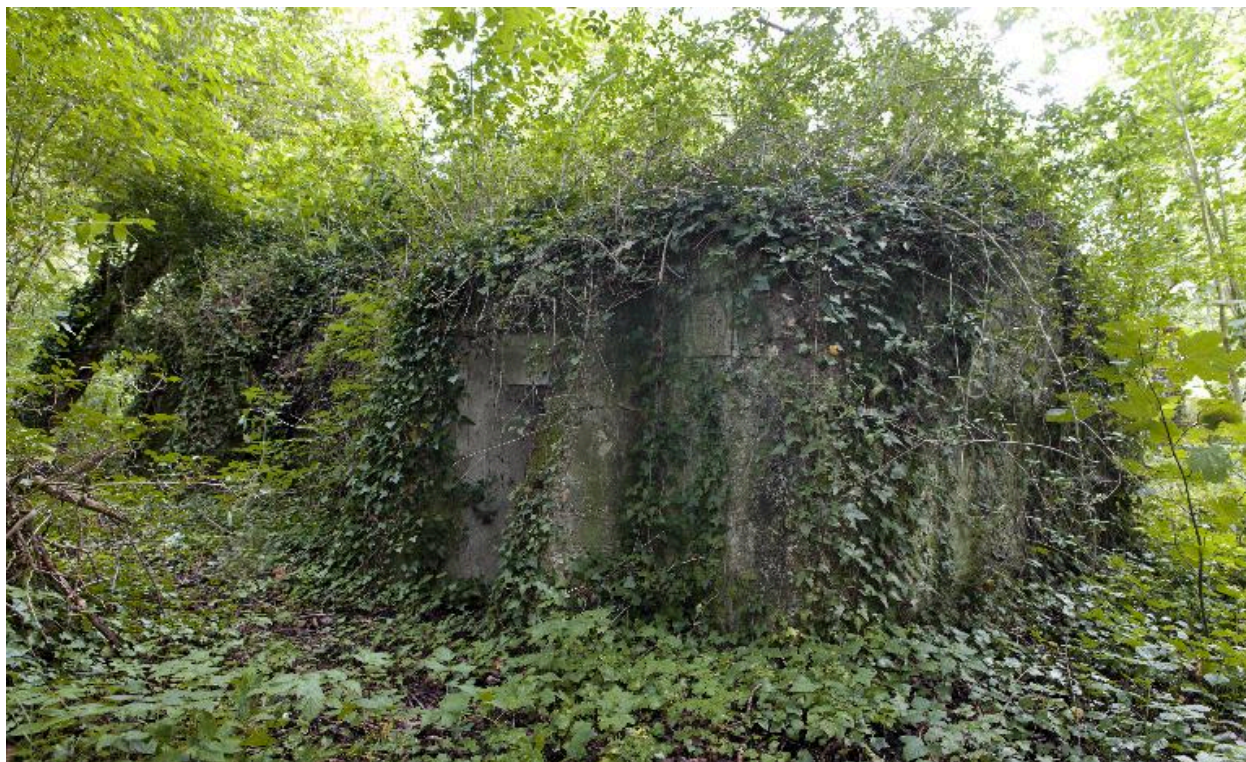
Casemate c) : Vue générale
