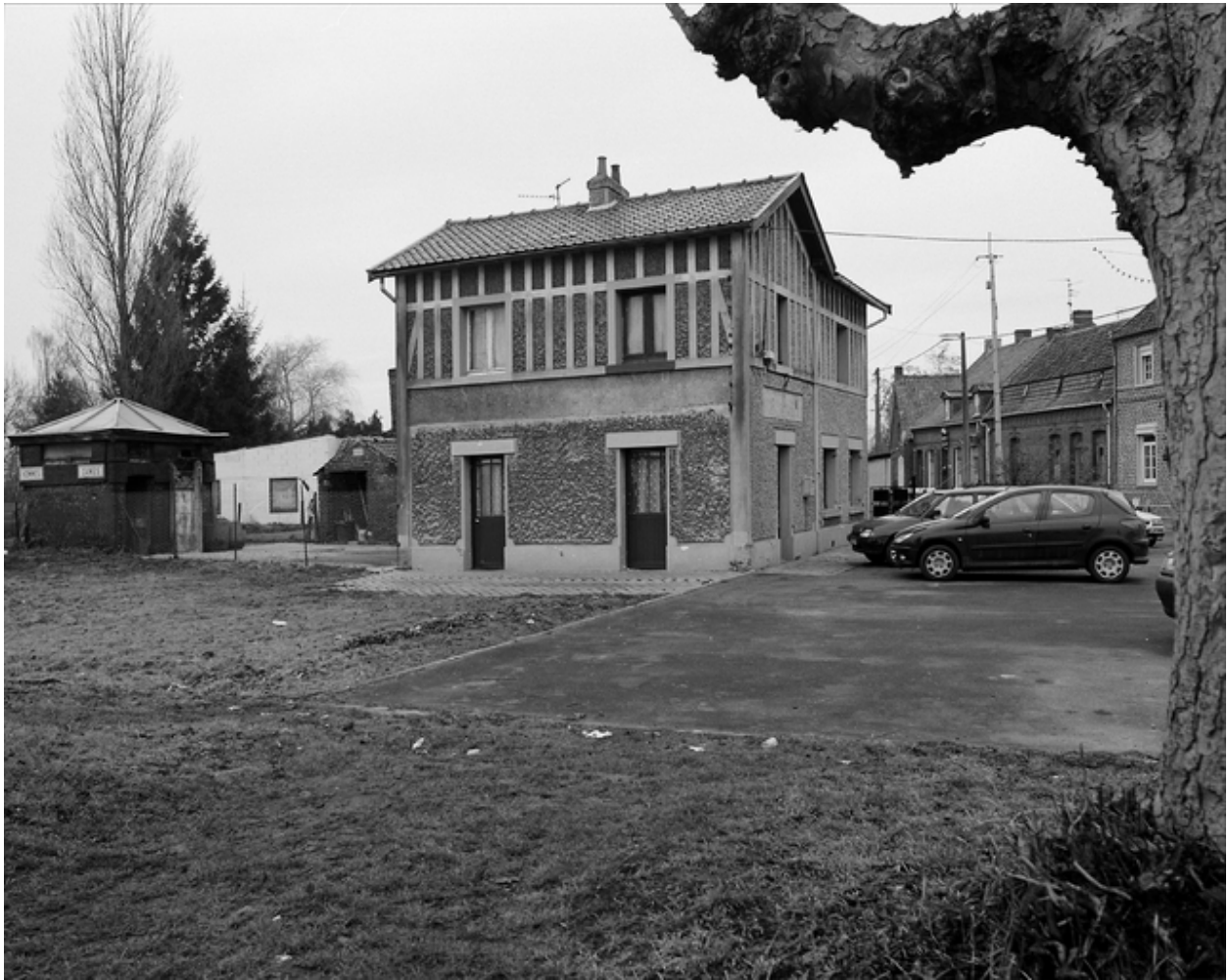
Vue générale, depuis la rue Jacques-Varlet.
