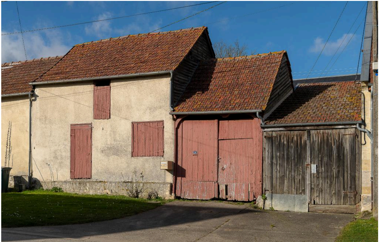
Bâtiment de grange et d'atelier de serger (?) prolongé d'une entrée charretière, n°26 Grande Rue, vue depuis le sud.
