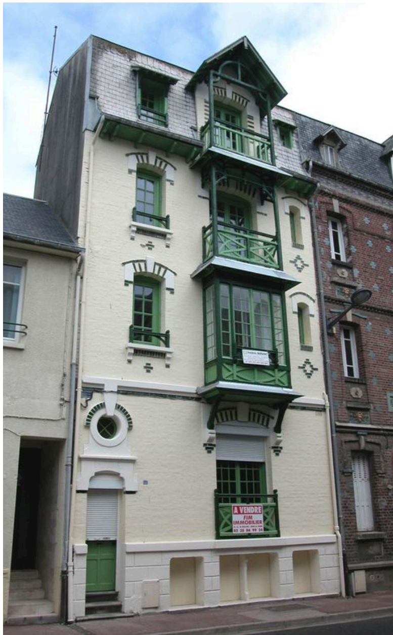
Vue d'ensemble après travaux (printemps 2004).
