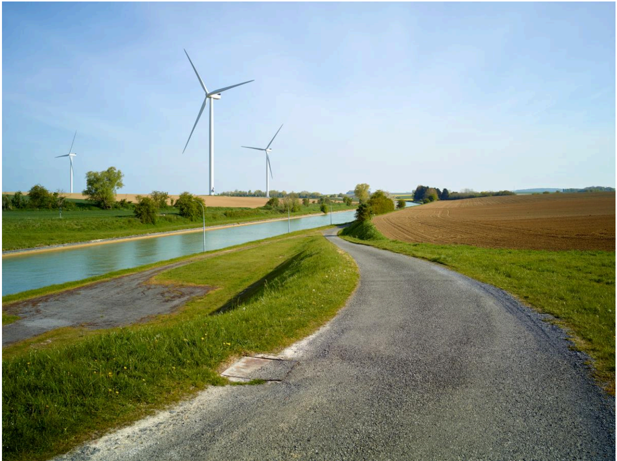
Vue générale du canal du Nord prise depuis la tête aval du site.
