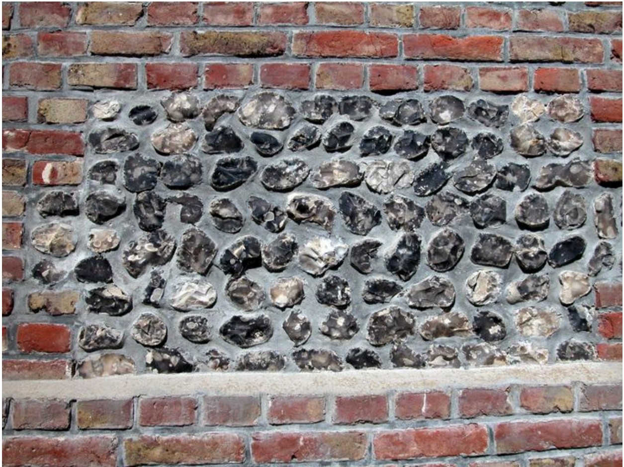
Détail du gros-oeuvre apparent.
