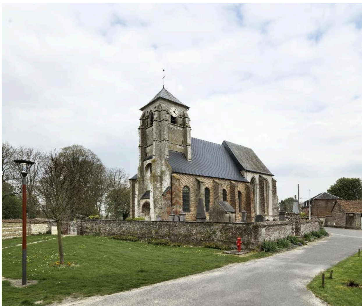
Vue générale depuis le sud-ouest.
