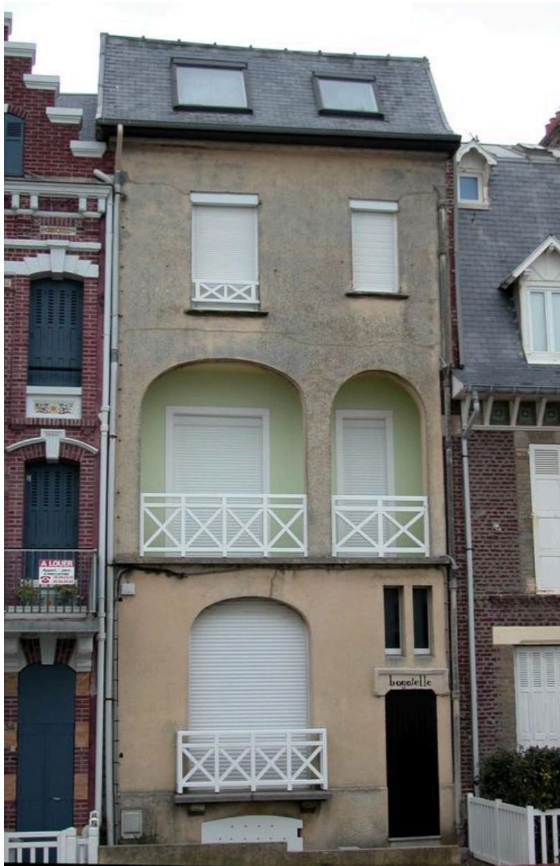
Vue d'ensemble depuis l'esplanade.
