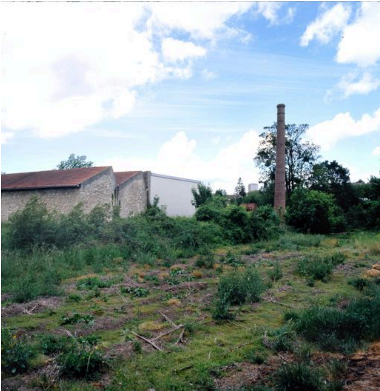
Cheminée d'évacuation des fumées et ateliers de l'usine de lacets.
