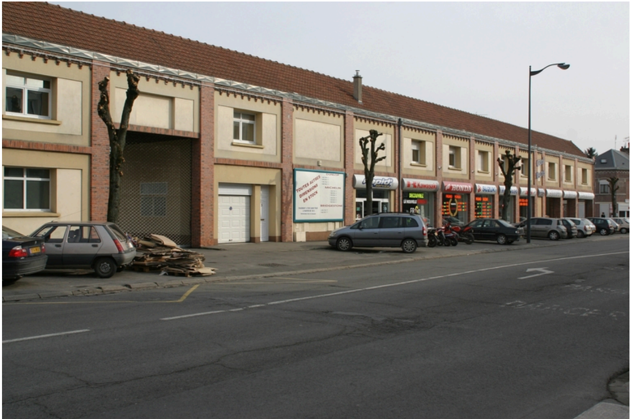
Façade des entrepôts et magasins de 1921, rue de La Fère.
