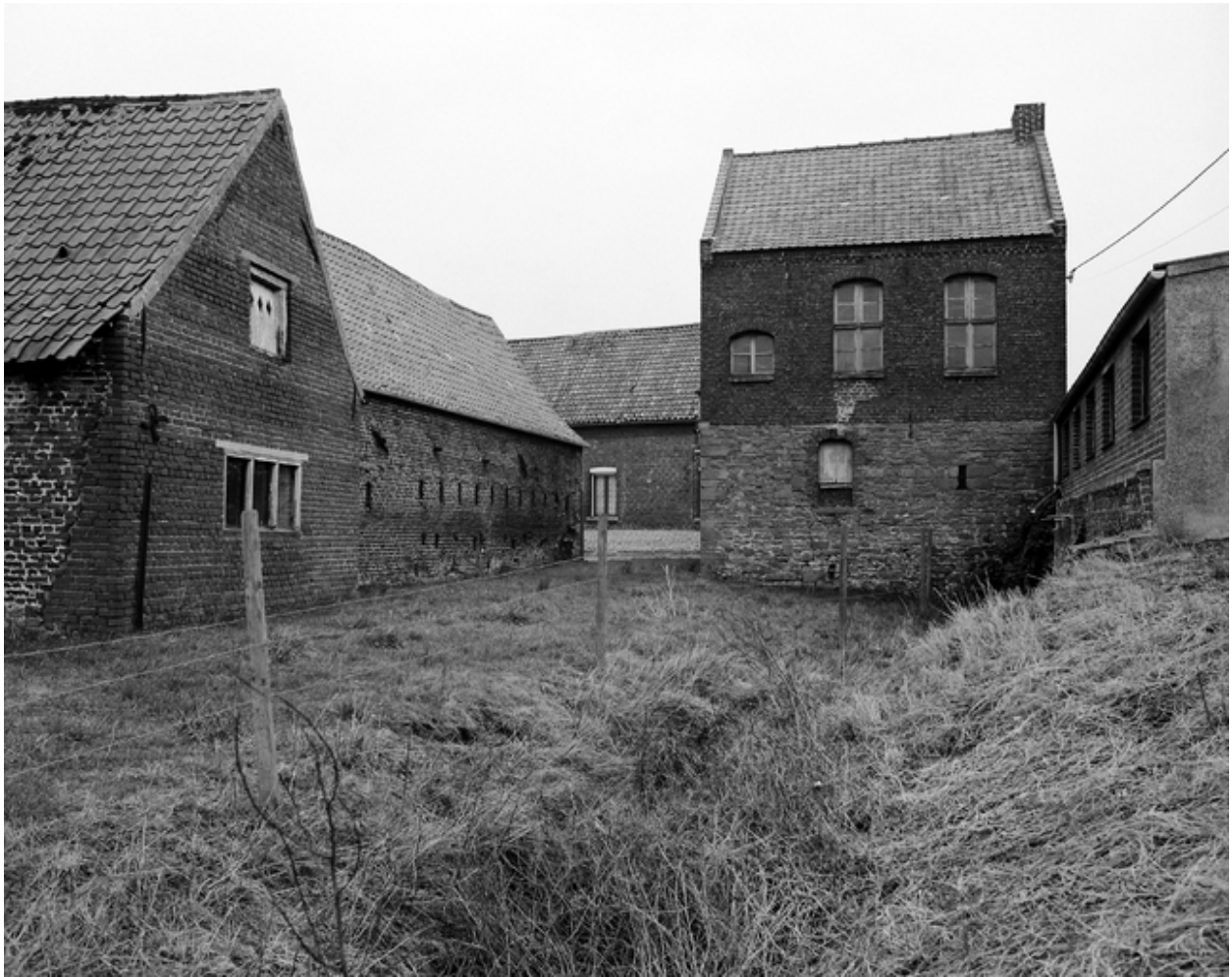
Elévations du bâtiment dit Playdoyable et étables depuis la rue.
