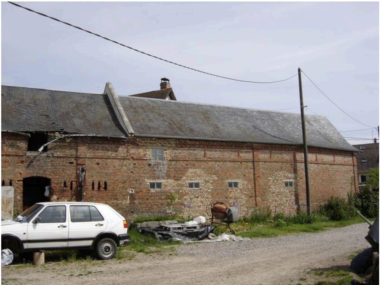
Vue des bâtiments de stockage.
