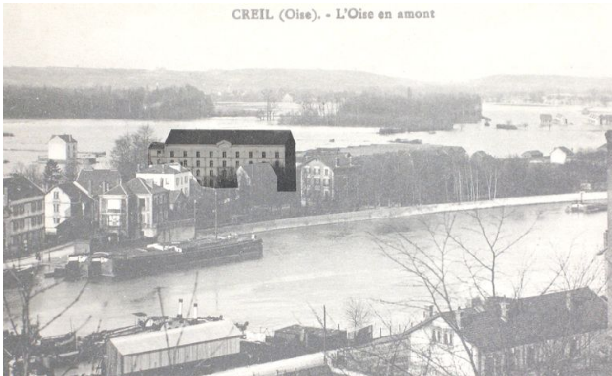
Usine II : moulin de Franchemont, début 20e siècle (AC Creil).
