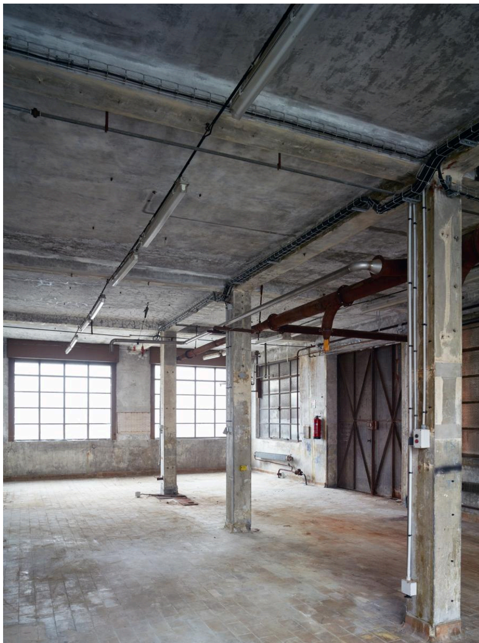
Vue intérieure de la menuiserie (I).
