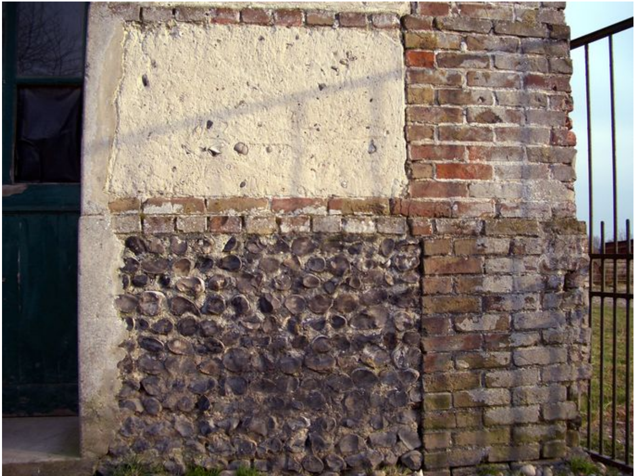
Détail de l'appareillage mixte des actuelles écuries.
