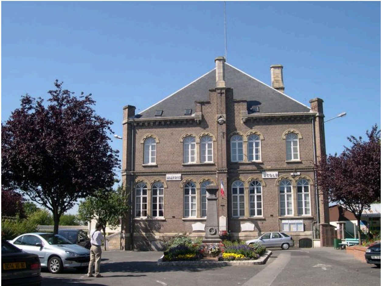
Vue générale, depuis l'est.
