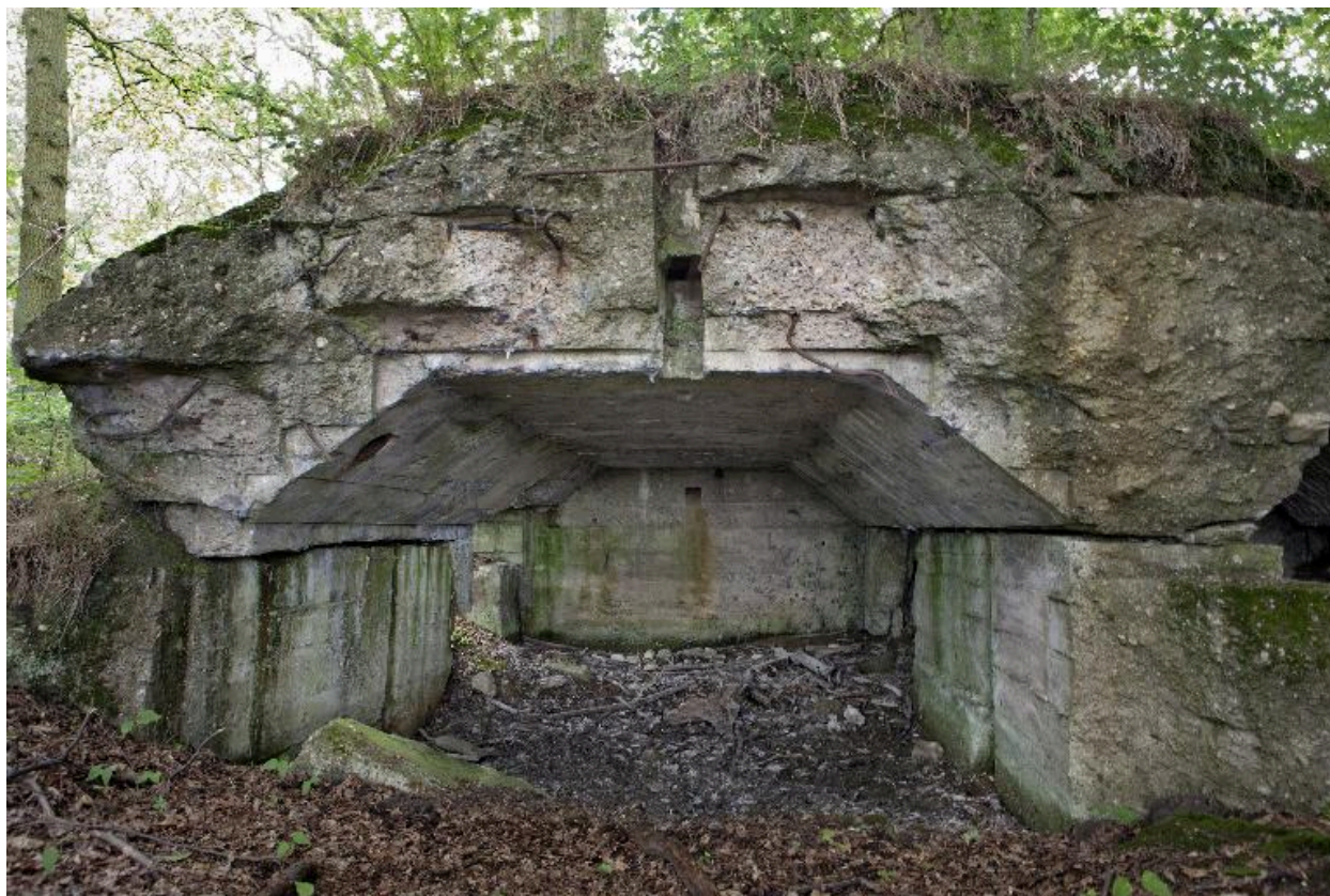
Casemate n°1, vue intérieure
