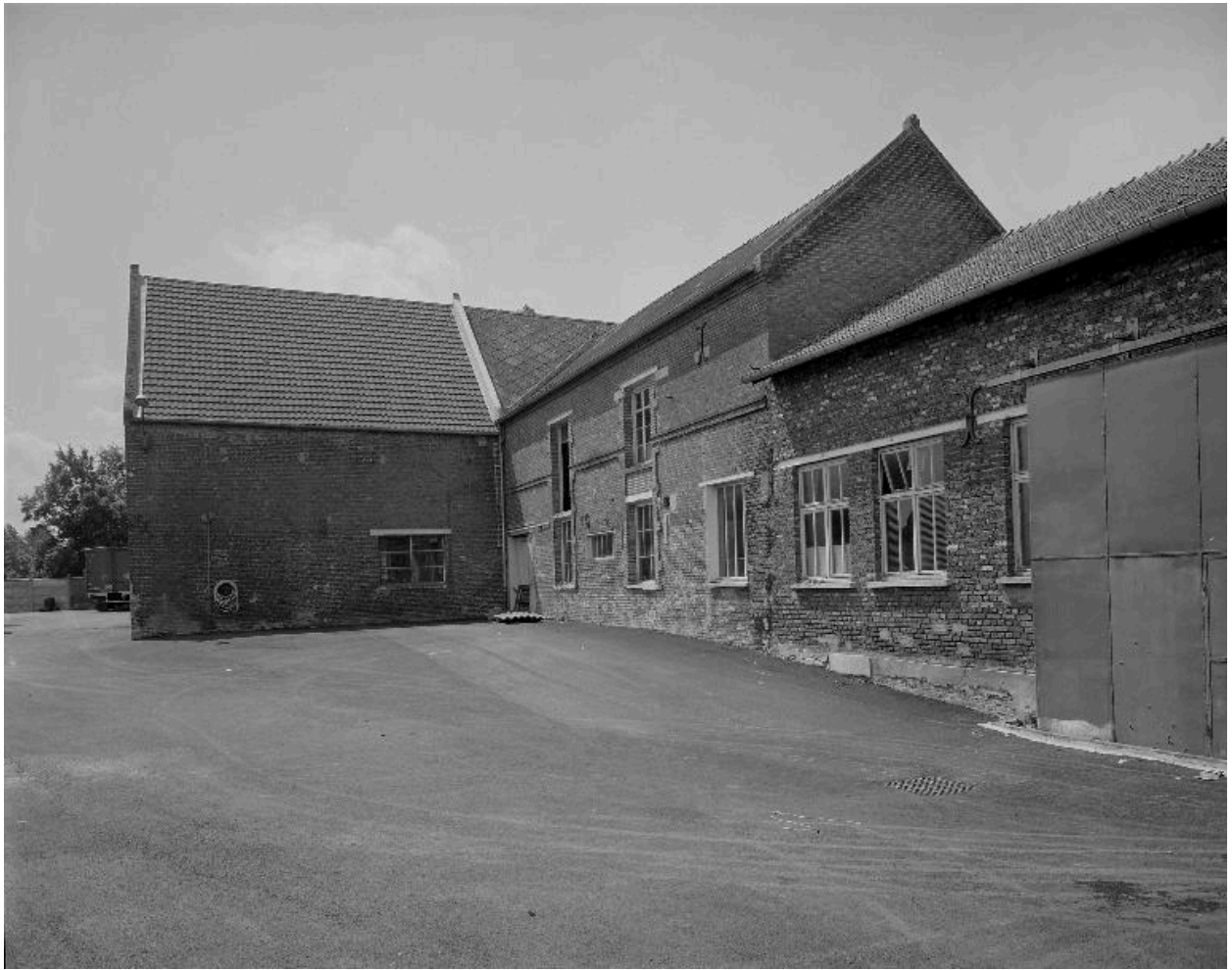
Atelier de fabrication, flanc est.
