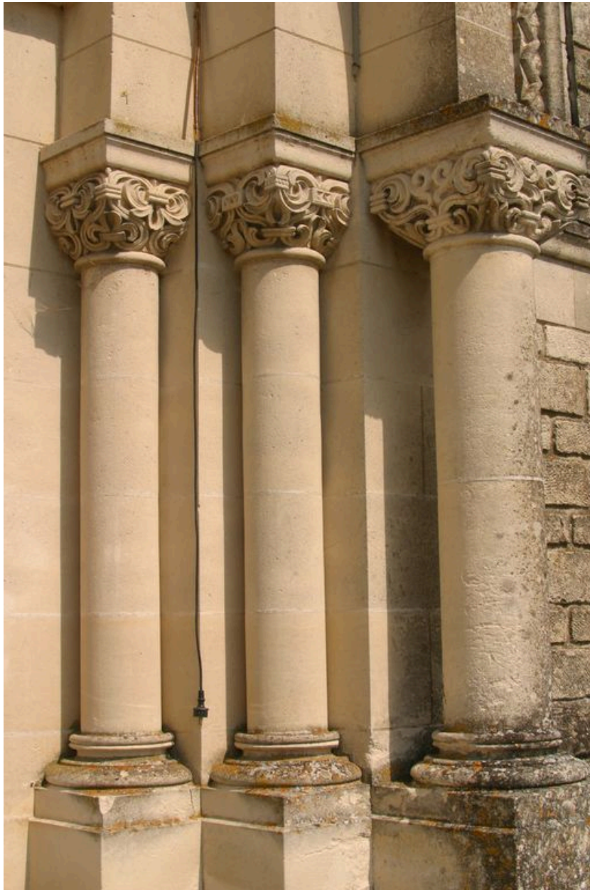
Détail des colonnes du portail.
