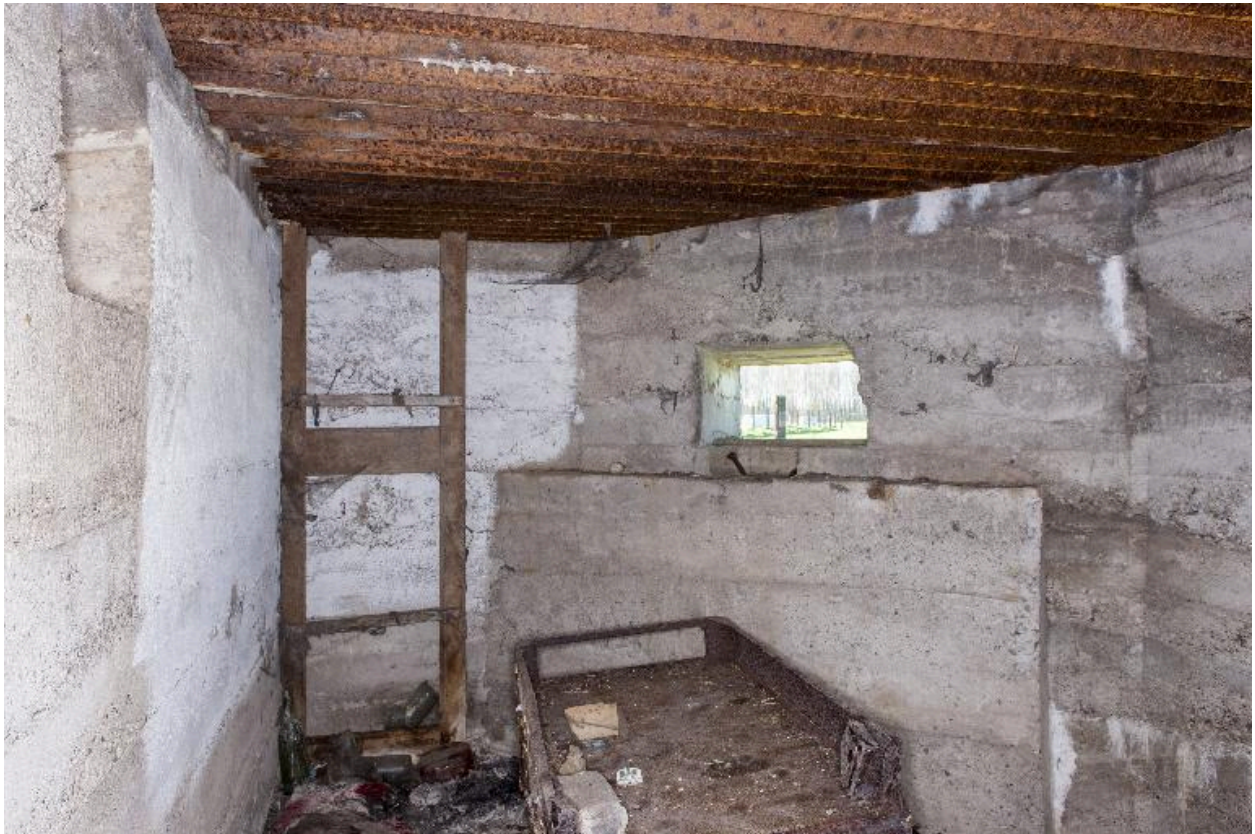
Casemate nord. Seconde salle. Ouverture de tir ouest.
