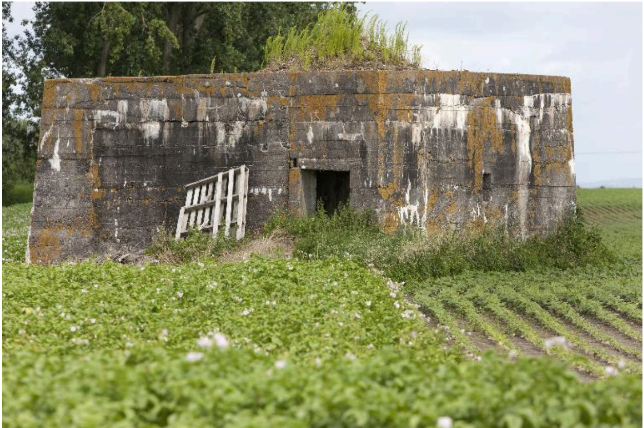
Vue vers le nord-ouest
