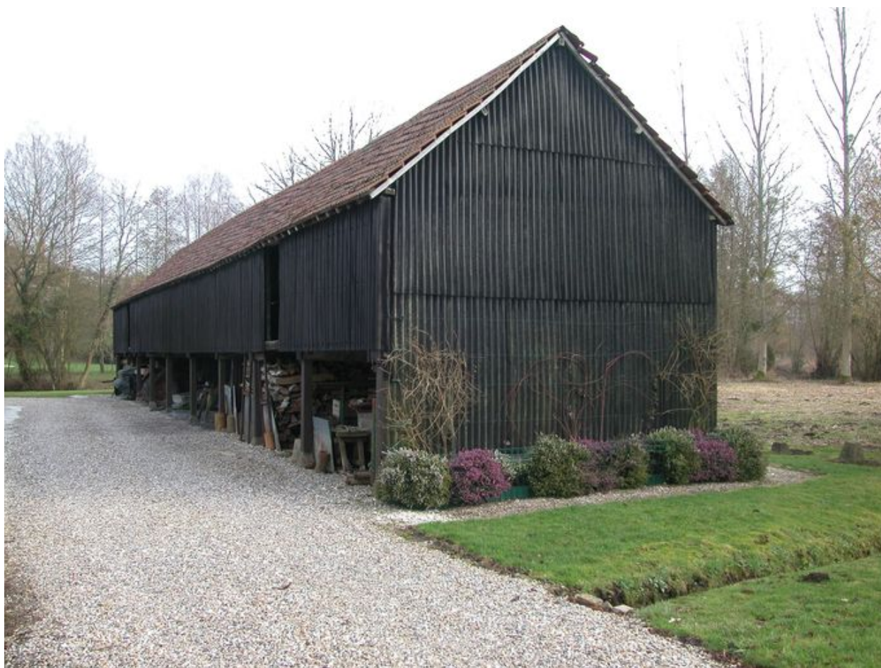
Bâtiment de stockage des bois, vue d'ensemble.
