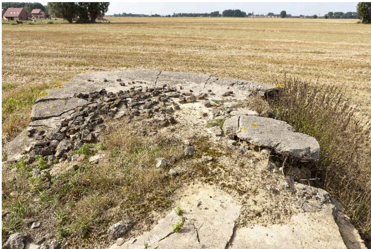
Vue du couvrement, vers l'ouest
