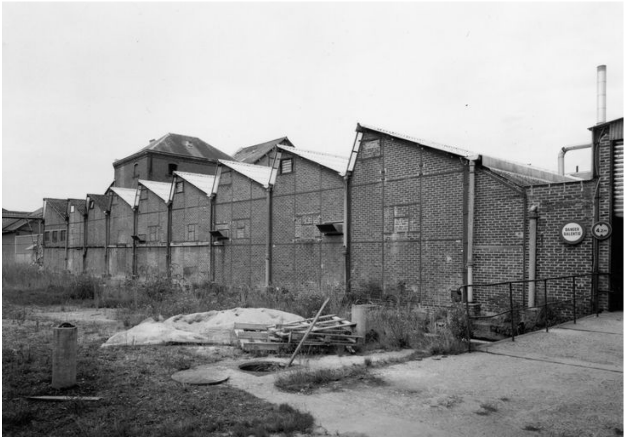
Les anciens ateliers de teinture, vus depuis le sud-est.
