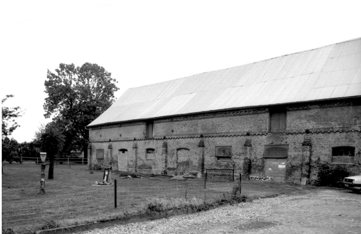
Vue partielle de l'étable sud.
