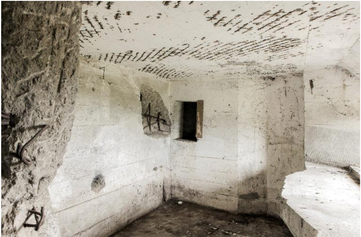
Premier étage, vue au grand-angulaire. A droite, appui pour mitrailleuse est
